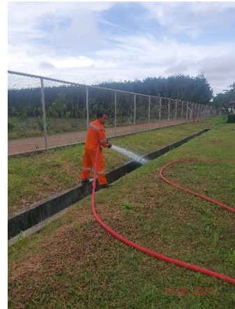
ภาพถ่ายที่ 2.2-11 การลอกท่อและร่องระบายน้ำในเขตสนามบิน
